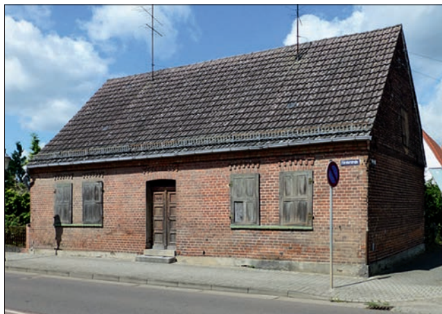
Wohnhaus mit ziegelsichtiger Fassade in spätklassizistischer Gestaltung
