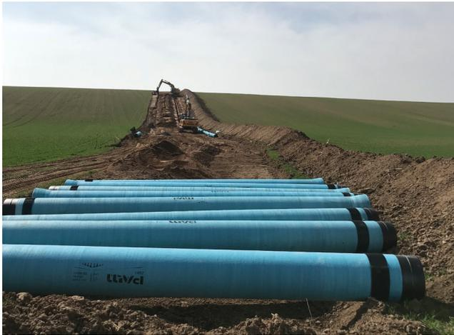
Aushub der Rohrschächte. Vorbereitungen für die Rohrverlegung der neuen Trinkwasserleitung.
