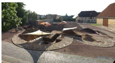
Abb. 1: Blick von Osten auf das Areal während der Freilegungsarbeiten.
