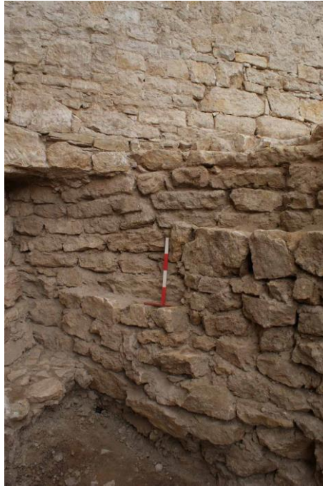
Abbildung 6 Die Binnenstruktur des Turms lässt Einbauten wie einen Treppenaufgang vermuten. © Landesamt für Denkmalpflege und Archäologie Sachsen-Anhalt, Ines Vahlhaus.
